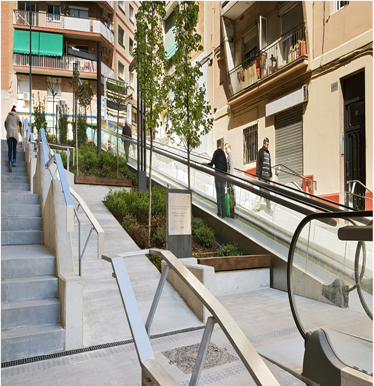
Millora accessibilitat C/Cuba Badalona. A. Buscemi i J. Bellmunt. Foto: Santiago Periel. © Mostres d'Arquitectura del Col·legi d'Arquitectes de Catalunya (COAC)
