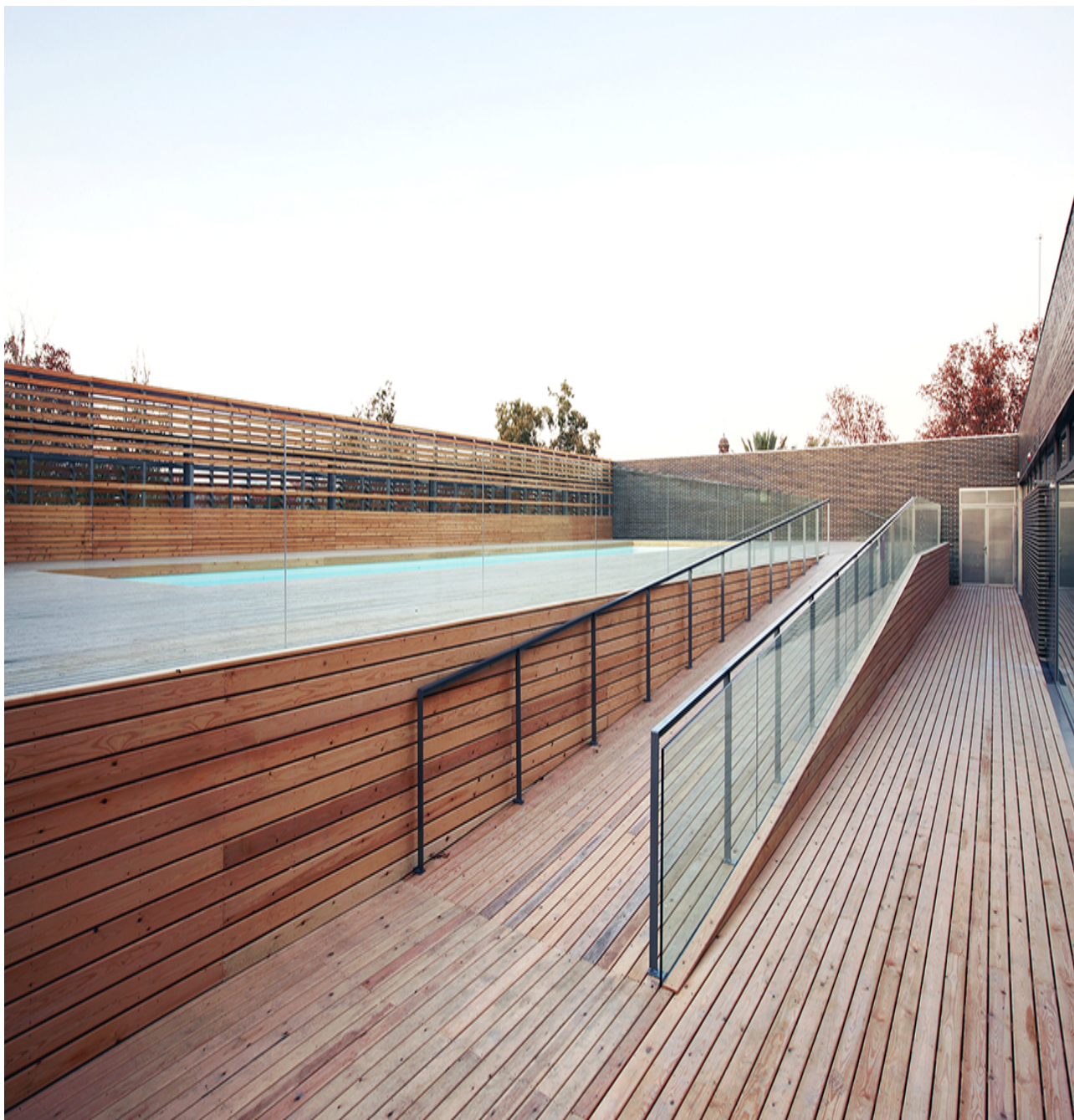
Pavelló Poliesportiu al Parc de la Ciutadella. Enric Batlle i Joan Roig. Foto: José Hevia i Jordi Surroca. Projecte seleccionat a la Mostra d'Arquitectura de Barcelona
