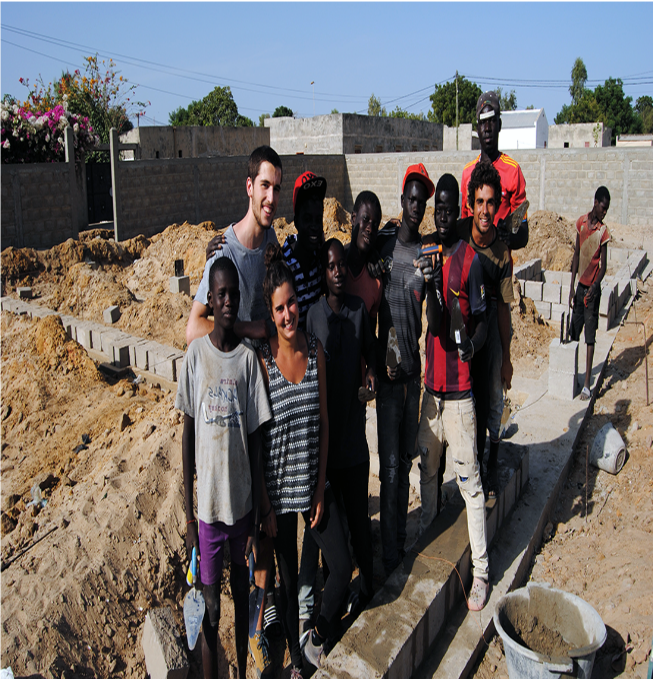
Building of a Library in Faoye, Senegal. Fundació Talibés (COAC Grants 2016)
