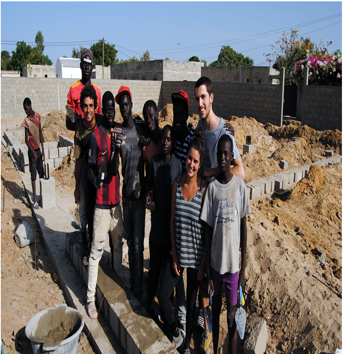
Construcción de una biblioteca en Faoye, Senegal. Fundación Talibés (Ayudas Cooperación 2016)
